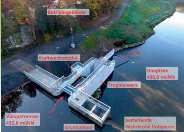
Anlagenteile der Wasserkraftanlage Eixendorf II
