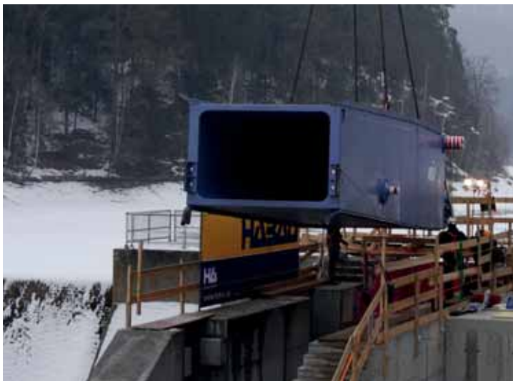
Einheben des Stahlteils in Betontrug
