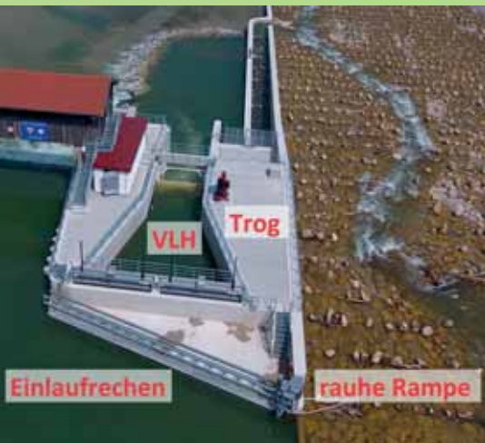
Kraftwerk Baierbrunn, Blick nach Unterwasser
