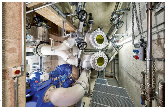
Bild 4: Schleusenammern und Steuerungstechnik der Fischabstiegsanlage
