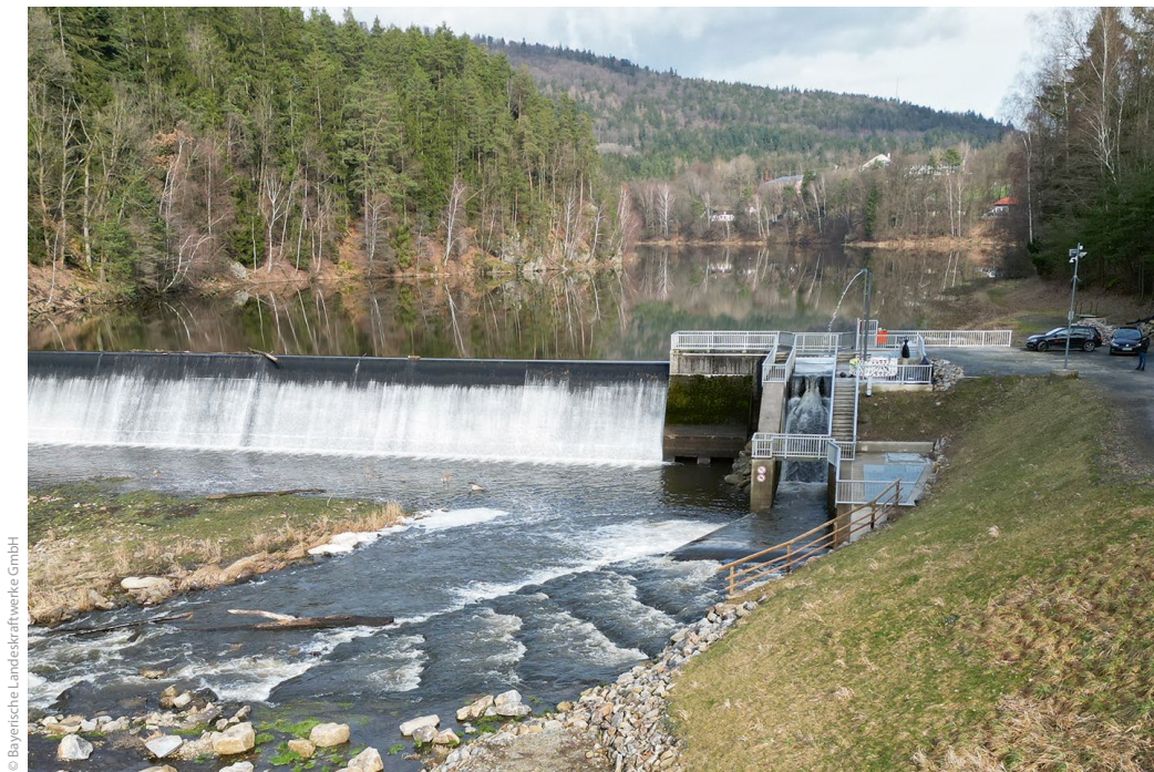
Bild 5: Vorsperre des Stausees Eixendorf mit beweglichem Wasserkraftwerk und Fischschleuse (Unterwasser ist zu diesem Zeitpunkt abgesenkt)
