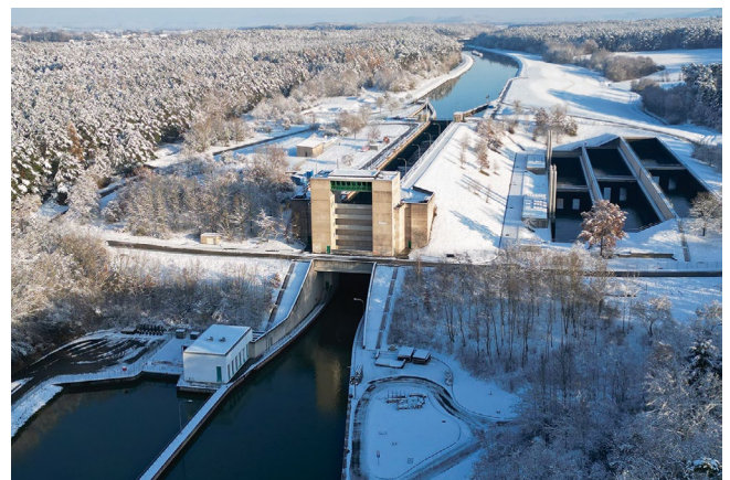
Bild 2: Schifffahrtsschleuse Hilpoltstein am Main-Donau-Kanal mit Wasserkraftwerk
